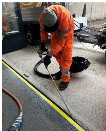
Dépose manuelle au sol d'un mastic d'étanchéité
